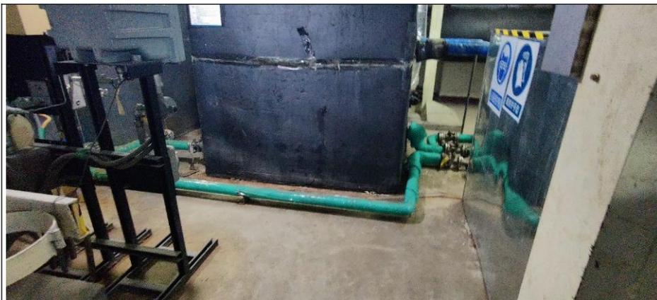
片基二部溶剂回收罐（不锈钢接地罐）
