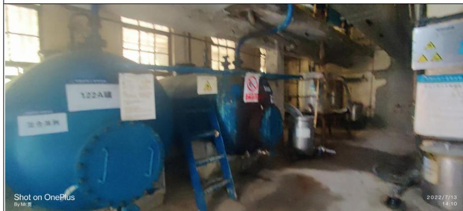
一部片基回收：溶剂罐（架空罐）
